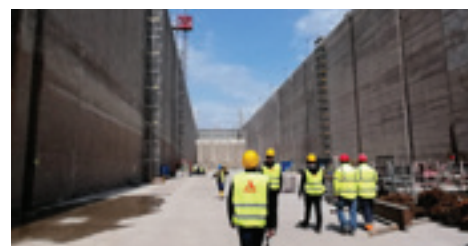
OPRAVA A OCHRANA BETÓNU
