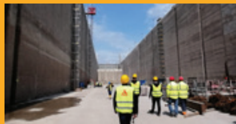
OPRAVA A OCHRANA BETÓNU
